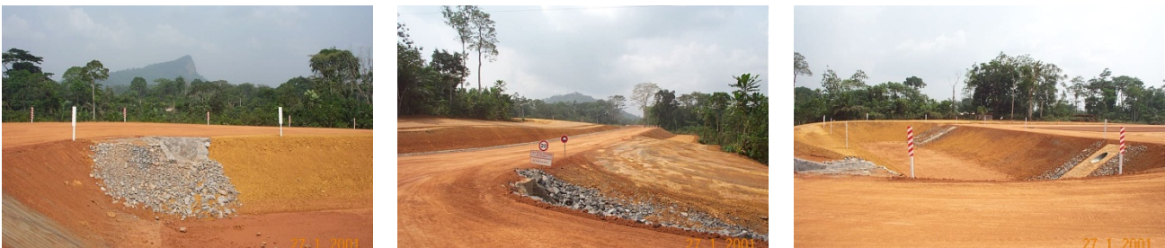
Figure 7.23 Lutte temporaire et permanente contre l'érosion combinée à Alufer Bel Air, Guinée
