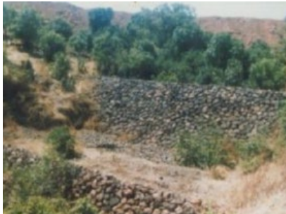
Figure 7.2 Barrages à limons en série et sédimentation dans des réservoirs à Hindalco Durgmanwadi, Inde
