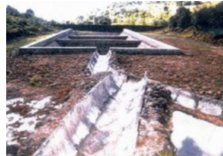
Figure 7.2 Barrages à limons en série et sédimentation dans des réservoirs à Hindalco Durgmanwadi, Inde
